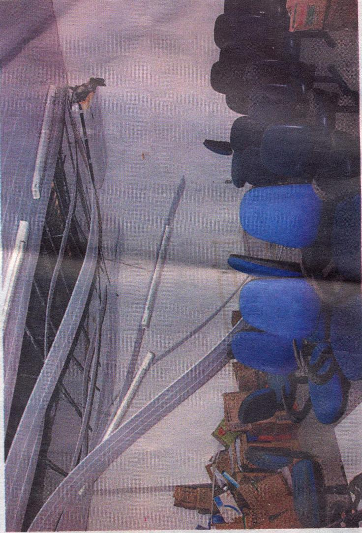
Forro do teto do auditório desabou, impedindo o funcionamento; há infiltração e rachaduras nas paredes
